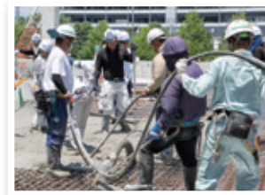
現場での施工風景
