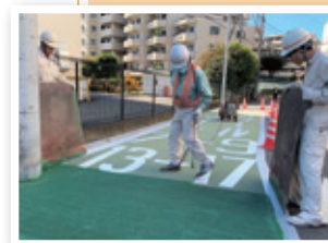
↓ 現場での作業風景
