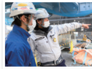
現場での作業風景
