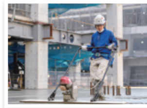
現場での作業風景
