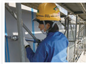
シーリング施工風景
