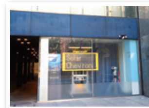
↓ 本社ビル外観
