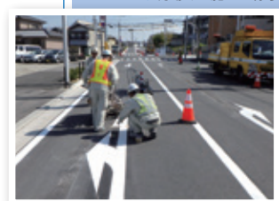
現場での施工の様子
